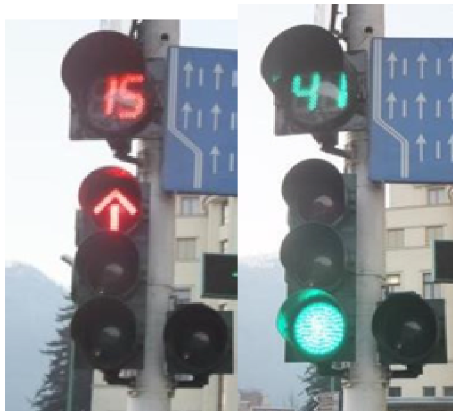
Figura 2.44 Temporizatoare tip „numărătoare inversă” la semafoarele pentru vehicule din intersecția Lunga – N. Iorga
