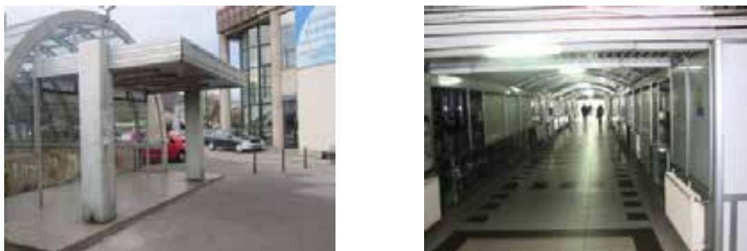
Figura 2.34 Pasaj subteran de la sensul giratoriu de pe Bulevardul 15 Noiembrie / Strada M. Kogălniceanu / Strada Iuliu Maniu
